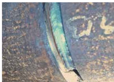
IAC - gyöksor lefelé történő függőleges hegesztése távfűtési csőben. A hegesztési sebesség jelentősen nagyobb a hagyományos felfelé történő hegesztéshez képest.
