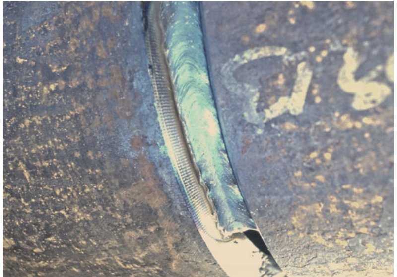
IAC – gyökvarratok függőlegesen lefelé hegesztése egy távfűtőcsőben. A hegesztési sebesség lényegesen nagyobb, mint a hagyományos, felfelé hegesztés esetén.
